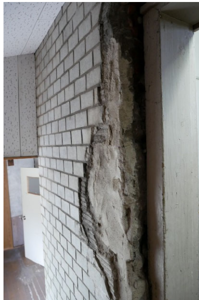
コンクリートの壁体とタイル張り
