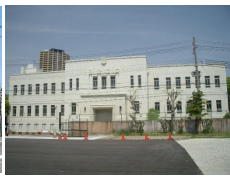
④旧尼崎警察署 兵庫県尼崎市、1926
